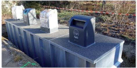
Hier sieht man den Fundamentkasten mit den einzelnen Sammelbehältern. Zum Schluß wird der Graben um den Kasten ebenerdig verfüllt.
